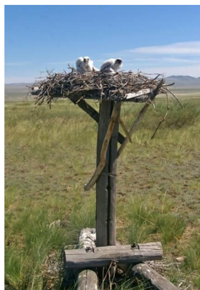
Рисунок 6-5. Устройство столбов с гнездовыми платформами или присадами: а) на железобетонной или металлической опоре (труба), б) на деревянной опоре
